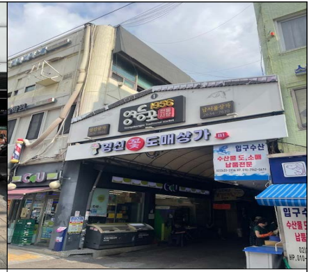
영신상가 LED 간판 설치
