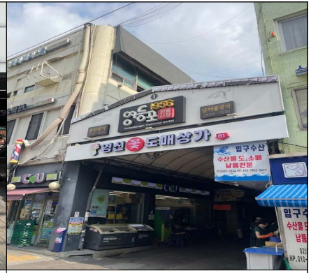
영신상가 LED 간판 설치
