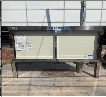
대림중앙시장 안내게시판 설치
