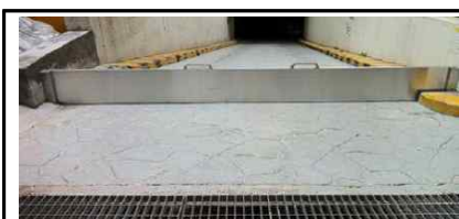
지하주차장 차수판 설치사진
